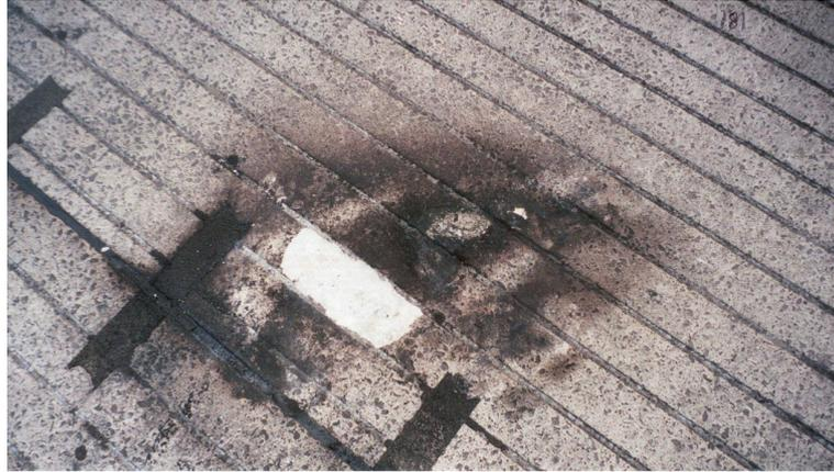
**Figure 12:** Photographie de la dalle 181 de la piste, montrant les traces de ce qui semble être une explosion avec arrachement d'un morceau de béton (10 cm de large, 25 à 30 cm de long, 1 cm d'épaisseur).
