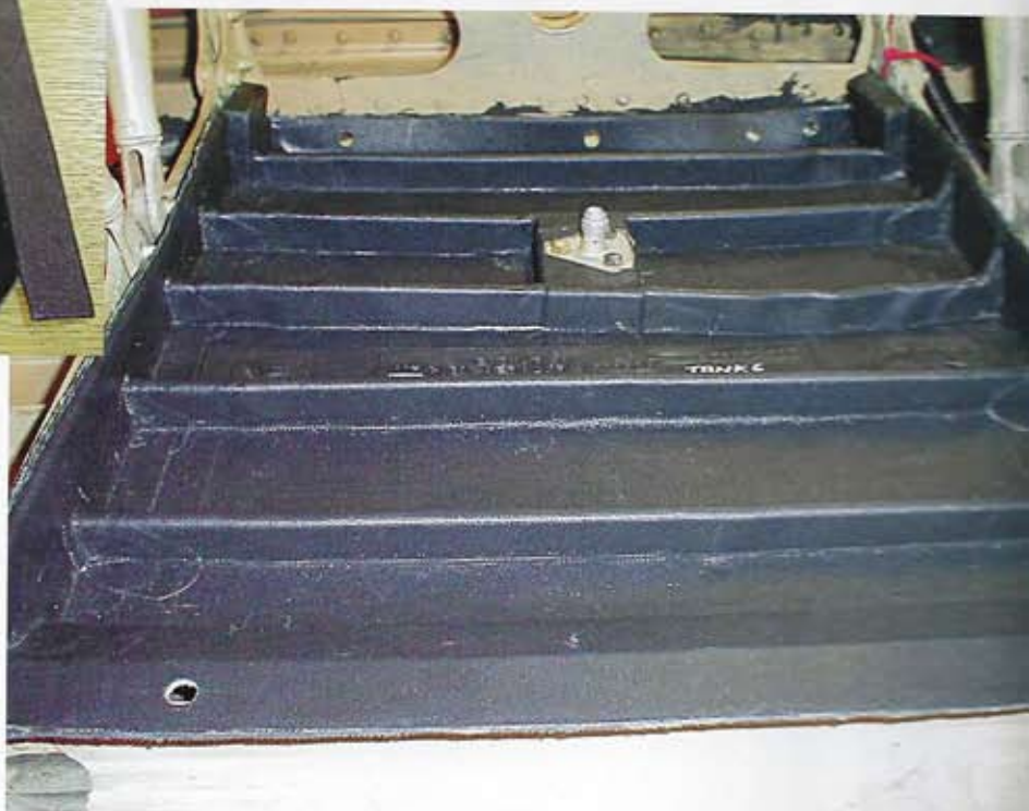
Le « Tankliner » posé sur la paroi interne du réservoir.
