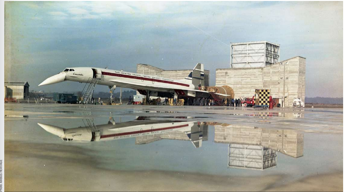
Toulouse : Premier dispositif d'atténuation de bruit – Banc d'essais des moteurs
