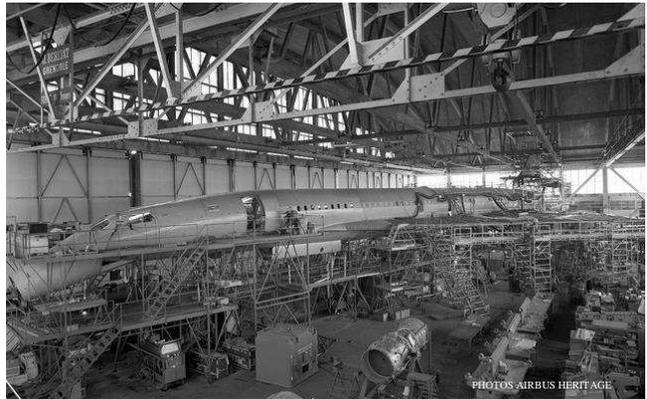
**Avril 1967. Assemblage final en cours et bien avancé du prototype et plus particulièrement, installation du nez basculant. Les trains d'atterrissage sont montés depuis le mois précédent.**
