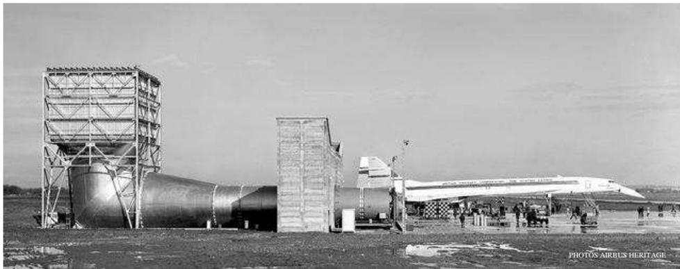
**4 février 1968 : Essais et mise au point des moteurs Olympus sur l'aire de points fixes équipée de grands déviateurs de jets et de bruits. Il semblerait que certaines tôles n'aient pas résisté à la première mise en puissance des moteurs et qu'elles se seraient véritablement envolées.**
