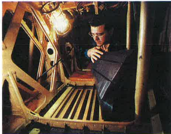
Installation des panneaux de Kevlar sur les fonds de réservoir.
