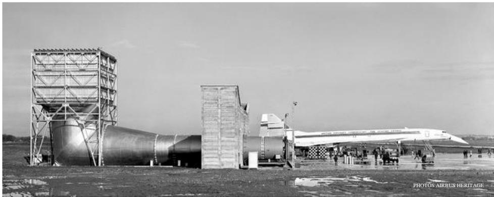
**4 février 1968 : Essais et mise au point des moteurs Olympus sur l'aire de points fixes équipée de grands déviateurs de jets et de bruits. Il semblerait que certaines tôles n'aient pas résisté à la première mise en puissance des moteurs et qu'elles se seraient véritablement envolées.**
